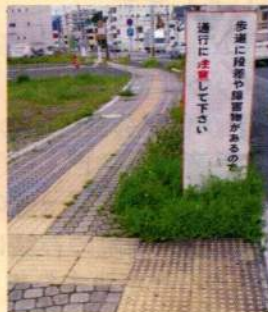
釜石市内の道路 (津波が通ったまま)
